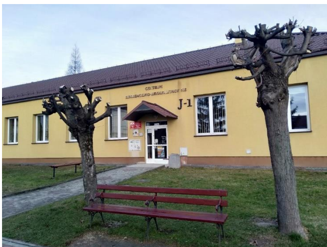
Fot. 6 Centrum rekreacyjno-rehabilitacyjne
