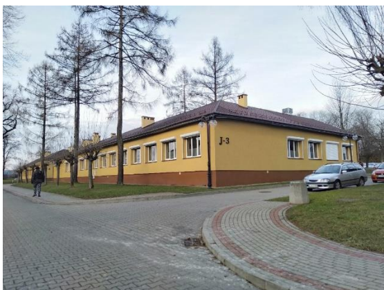
Fot. 8 Budynek J3
