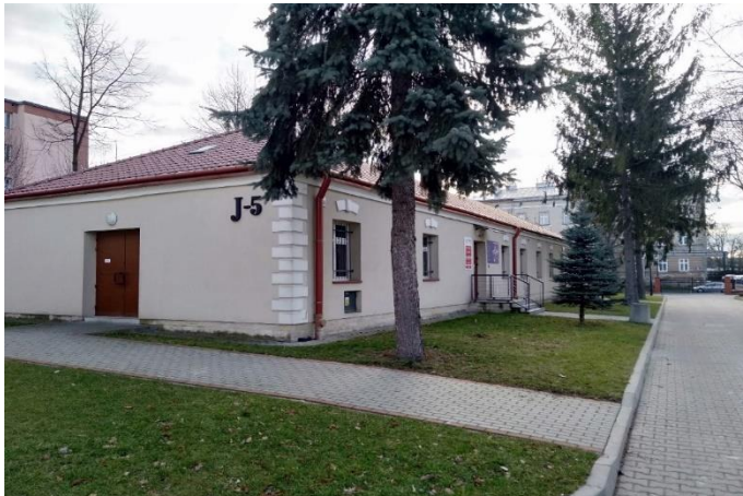
Fot.12. Budynek J5
