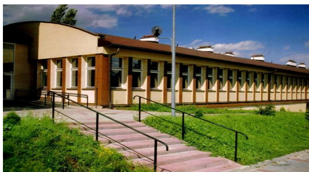
Fot. 18. Budynek B.
