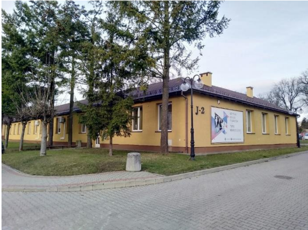
Fot. 7 Budynek J2
