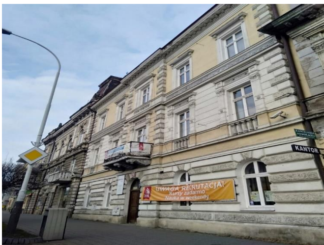
Fot. 20. Budynek Dydaktyczny WOZ
