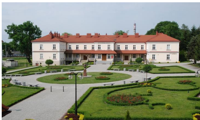
Fot. 2. Wydział Inżynierii Technicznej
