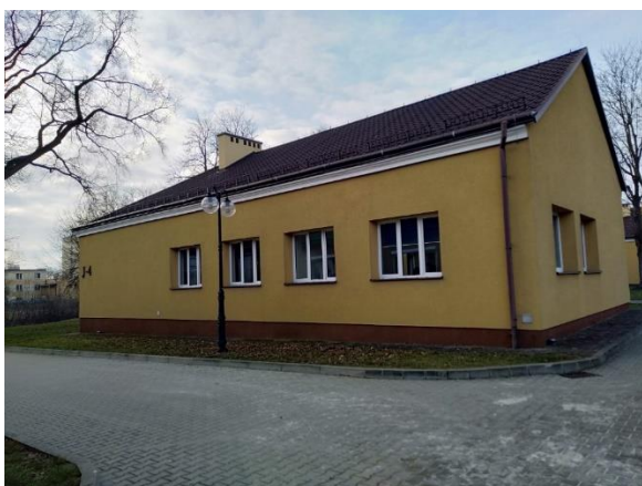
Fot. 9 Budynek J4
