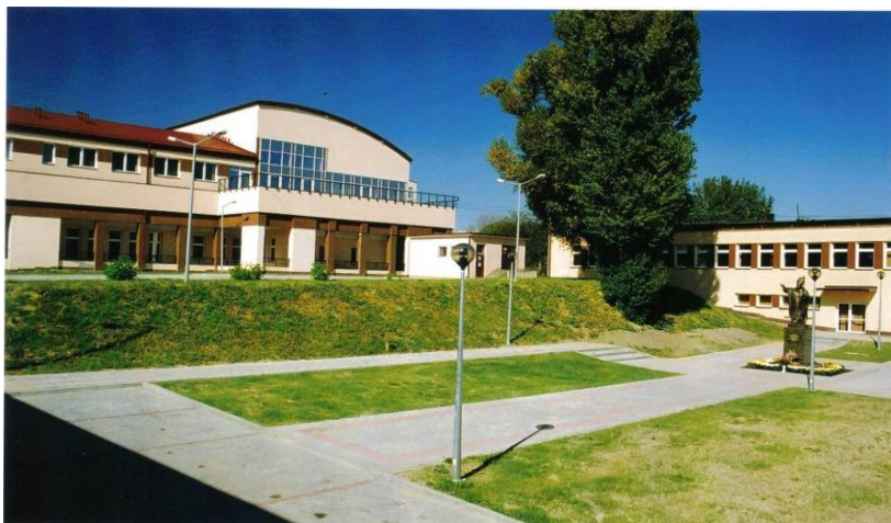
Fot. 19. Budynek C
